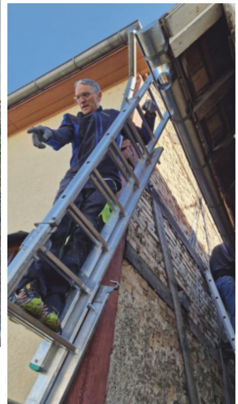
L'ancienne gouttière était percée, les écoulements généraient des infiltrations dans les locaux.
