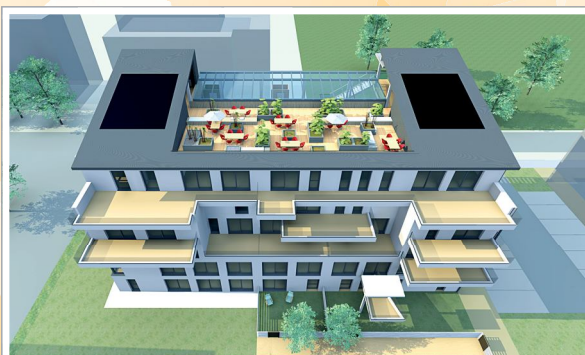
Maquette d'une installation de 36 kWc sur un immeuble construit par une coopérative d'habitants à Cronembourg, Bas-Rhin
